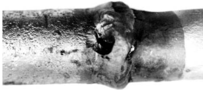
Рис. 3. Дефект зварного з'єднання (свищ), виявлений під час експлуатації водяного економайзера
