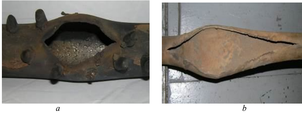
Рис. 6. Труба НРЧ після короткочасного перегріву металу до 850 °С (а) та пошкоджена ділянка труби НРЧ після 7398 h експлуатації (b). Fig. 6. The pipe of lower radiation part after short-term overheating of metal up to 850 °С (a) and damaged pipe section of lower radiation part after 7398 h of operation (b).
